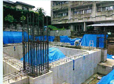
型枠脱型時
