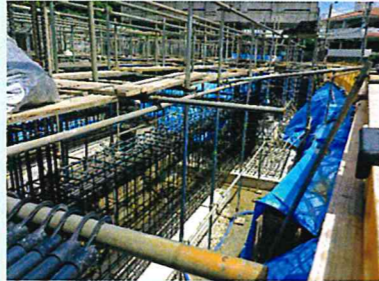
基礎配筋検査時
